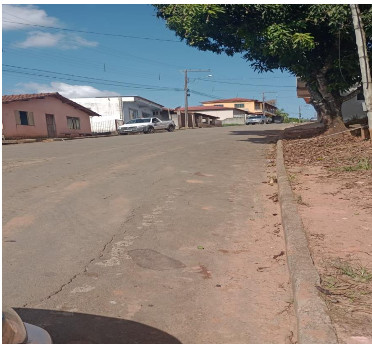
Projeto 9 - Rua Isaac Rodrigues, Distrito São Bartolomeu de Minas
