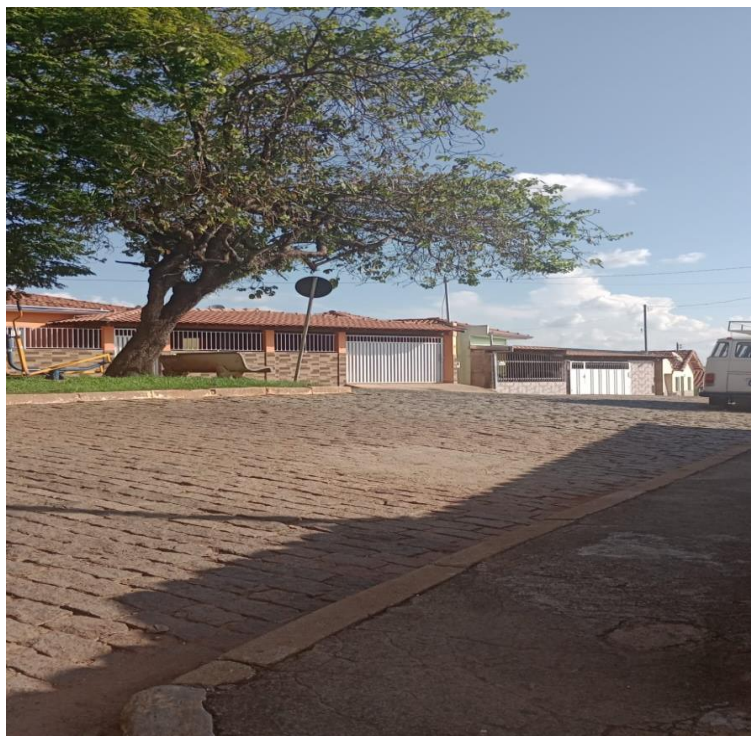
Projeto 5 - Rua Vargem São José, Bairro Chapadão
