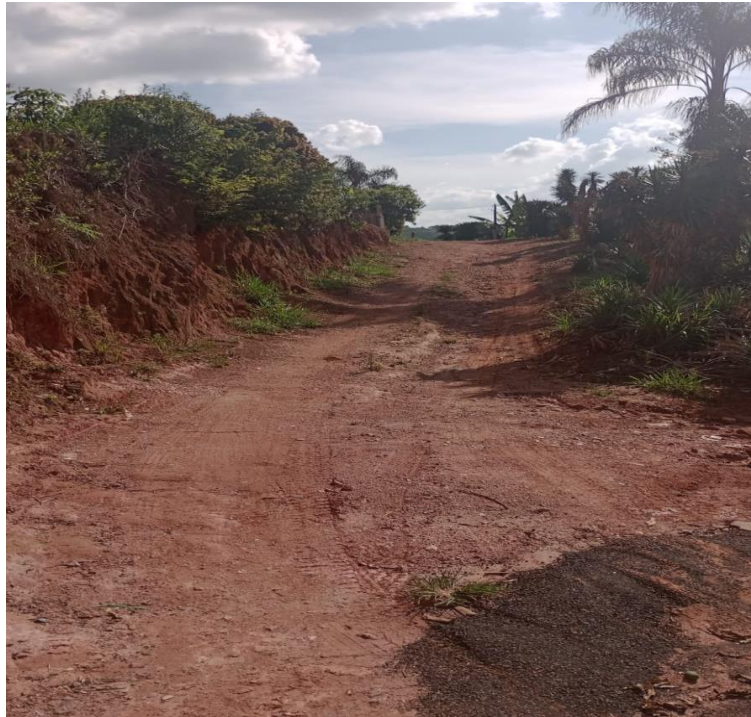
Projeto 9 - Rua Isaac Rodrigues, Distrito São Bartolomeu de Minas
