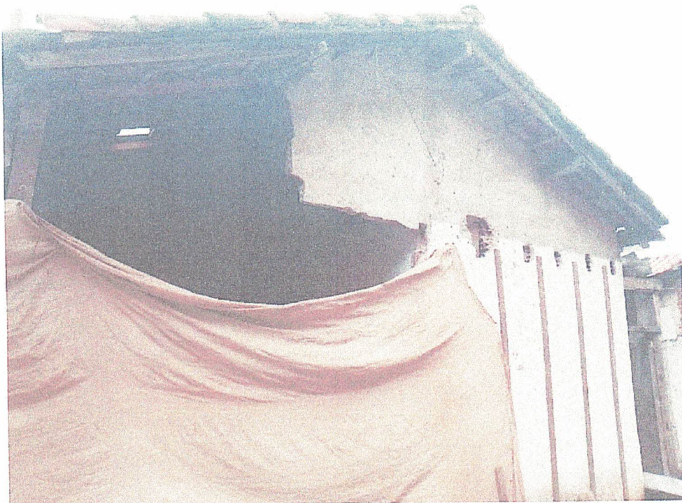
Foto 01: parede demolida da cozinha
