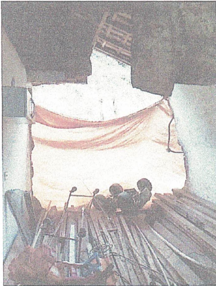
Foto 02: parede demolida da cozinha
