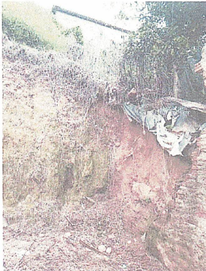
Foto 06: parede demolida do lado direito da área de serviço
