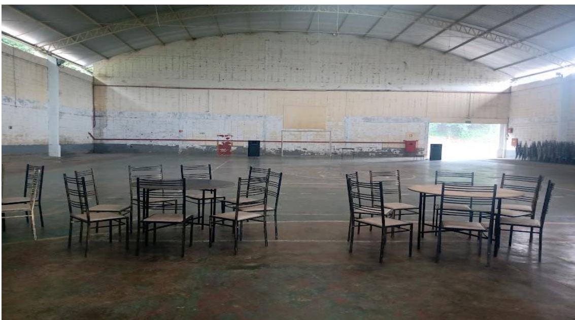
Figura 5 - Paredes internas, vista dos fundos
